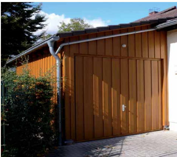
TBS hat für jedes bauliche Umfeld das passende Garagentor
